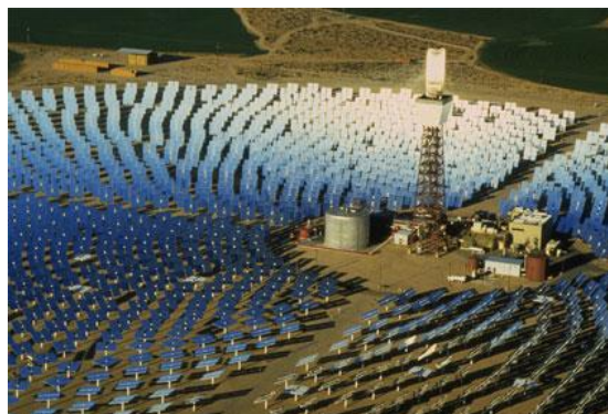
Paneis de enerxía solar. Na parte central, obsérvase o colector de enerxía, cara ao que se dirixen todos os paneis.
