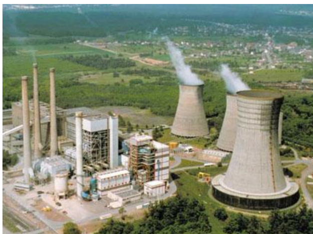
Central térmica. Moitas destas centrais utilizan o carbón como combustible
