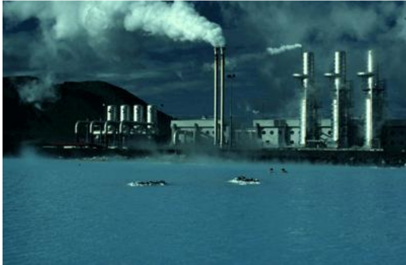
Central xeotérmica en Islandia
