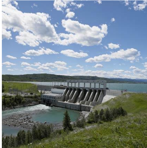
Vista dunha presa con central hidroeléctrica (parte esquerda)
